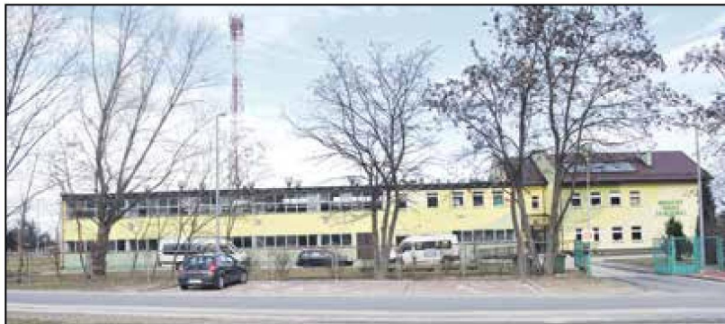
Widok na istniejący budynek
